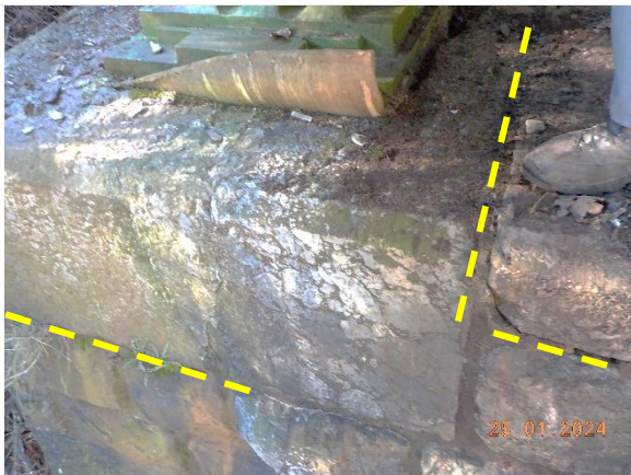
sl.53- opornik stran Sežana: kamniti bloki ob levem nepomičnem ležišču
