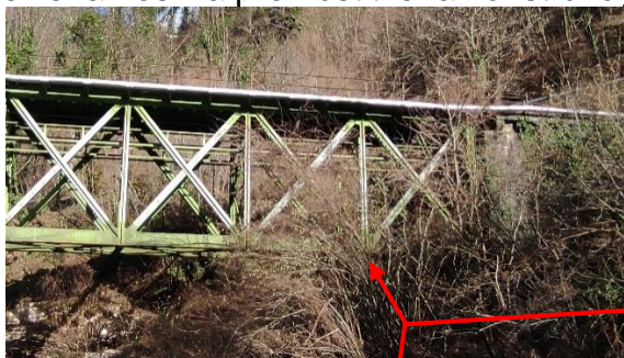
sl.1- gorvodni glavni palični nosilec: vezna pločevina spodnjega pasu močno korozijsko poškodovana
