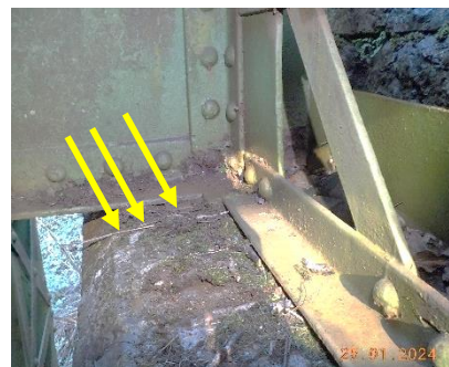
sl.56- oporni zid sekundarnega vzdolžnika-stran Jesenice/dolvodno: horizontalne razpoke kamnitega bloka
