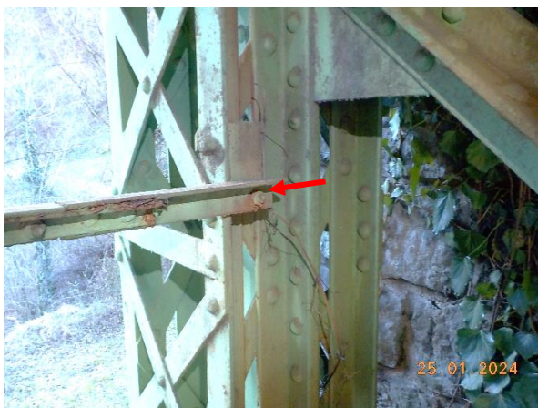
sl.9- ograja v servisnem hodniku / gorvodna stran / nad ležiščem stran Sežana: odtrgan vijak pritrditve ograje na vertikalo znotraj paličnega nosilca Sanacija: DA
