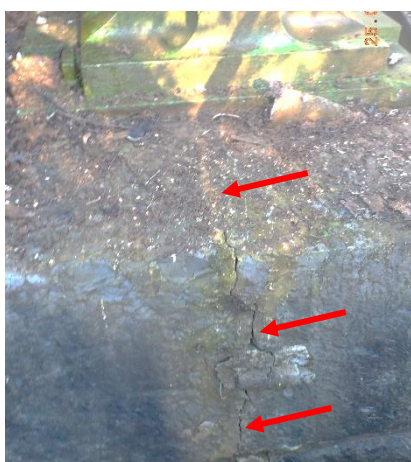
sl.33- opornik stran Sežana: gorvodno ležišče: kamniti blok – razpoka na bočni strani
