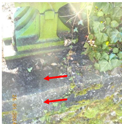
sl.35- opornik stran Sežana: dolvodno ležišče: kamniti blok – razpoka na bočni strani
