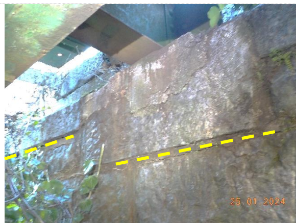
sl.47- oporni zid sekundarnega vzdolžnika-stran Sežana/gorvodno: lokacije preperelih fug med kamni pod drsnim ležiščem
