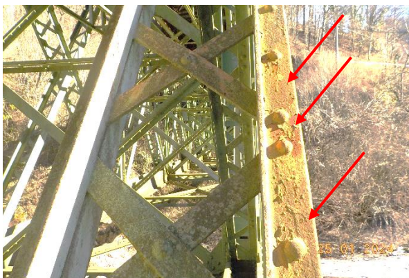
sl.5- na več elementih opažen pojav korozije vendar brez večjih korozijskih poškodb površin oz. poškodb spojev med konstrukcijskimi elementi Sanacija: v sklopu celovite obnove PKZ konstrukcije
