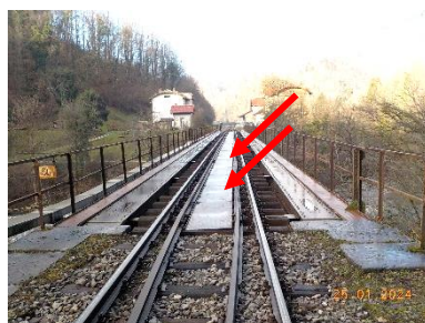
sl.45- sredinska pohodna pločevina med tiroma lokalno upognjena /deformirana
