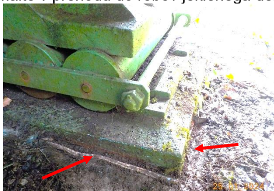
sl.30-primer odkrušenja malte ob prehodu na sp. ploščo
