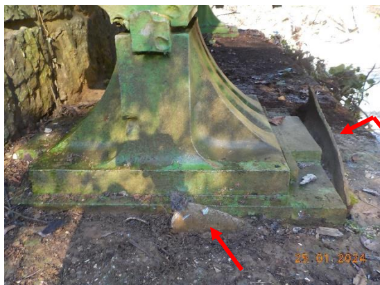
sl.31- opornik stran Sežana: gorvodno ležišče – iztisnjena svinčena plast
