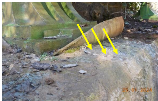
sl.55- opornik stran Sežana: nepomično ležišče /gorvodno: horizontalne razpoke kamnitega bloka
