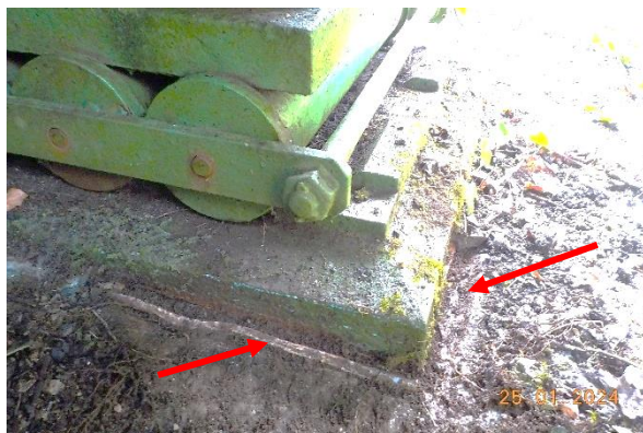
sl.63- primer na pomičnem ležišču / stran Jesenice, izvesti naklonski prehod reparaturne malte
