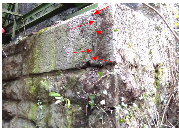
sl.57- opornik stran Jesenice/gorvodno: pomično ležišče : vertikalne razpoke kamnitega bloka
