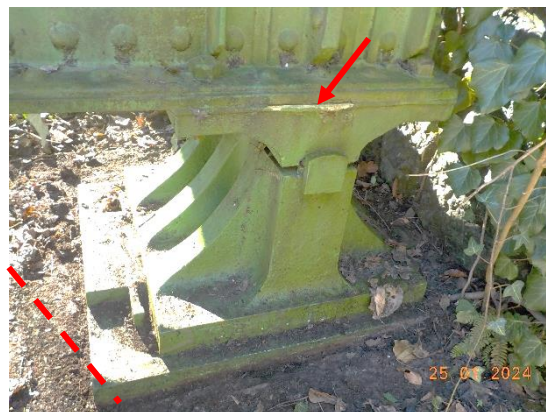
sl.32- opornik stran Sežana: dolvodno ležišče – iztisnjena svinčena plast
