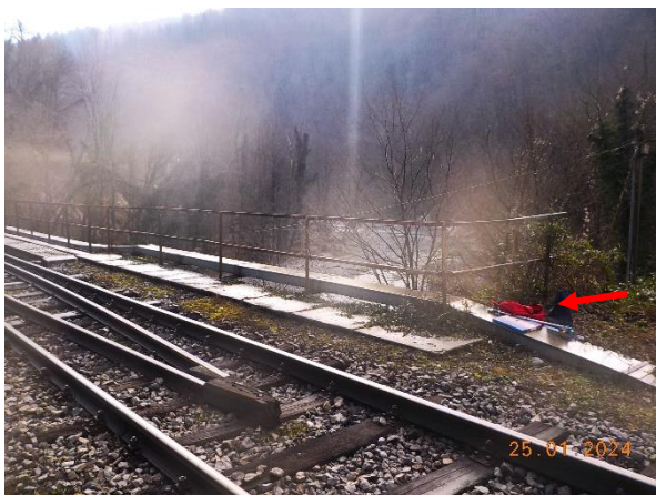
sl.13- ograja na levem krilu opornika stran Sežana, prekoračeni stebrček ograje – označeno s puščicami. Sanacija: DA
