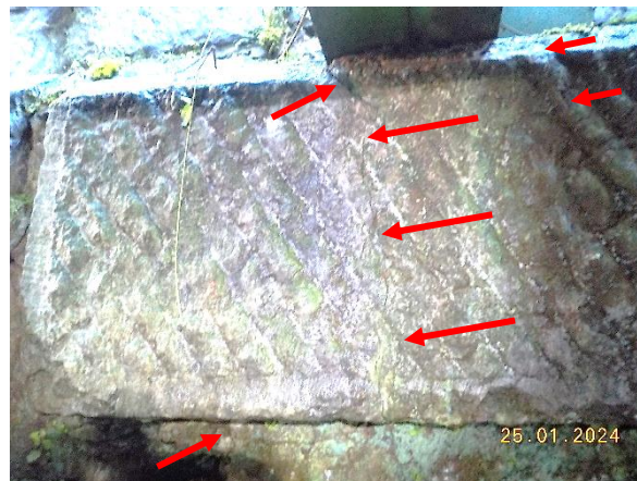
sl.41- opornik sek. vzdolžnika stran Jesenice: dolvodno posedel kamniti blok / razpoka na čelni strani bloka / preperela fuga ob in pod kamnom
