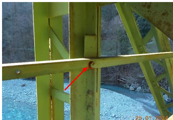
sl.8- ograja v servisnem hodniku / gorvodna stran: na cca. 3-4 pritrditvah ograje na vertikalo znotraj paličnega nosilca je vijak poškodovan/delno odtrgan/prekorodiran (majav ročaj ograje) Sanacija: DA
