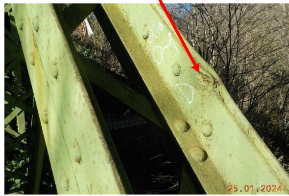
sl.6- močna plastična poškodba robu elementa / deformacija roba kraka brez bistvenega zmanjšanja nosilnega prereza Sanacija: NE
