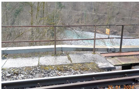
sl.22- levo krilo stran Jesenice: razpadle fuge med kamni, poraščenost z mahom
