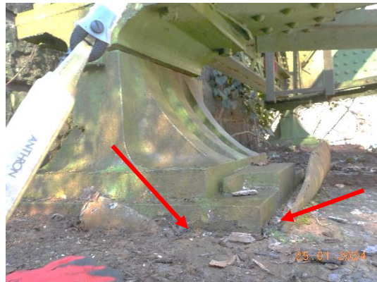
sl.64- primer na nepomičnem ležišču / stran Sežana, prekomerno izstopajočo svinčeno ploščo se poreže, izvesti naklonski prehod reparaturne malte
