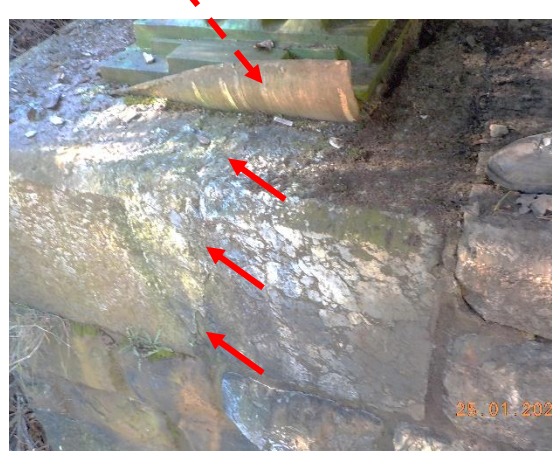
sl.34- opornik stran Sežana: gorvodno ležišče: kamniti blok – razpoka na čelni strani
