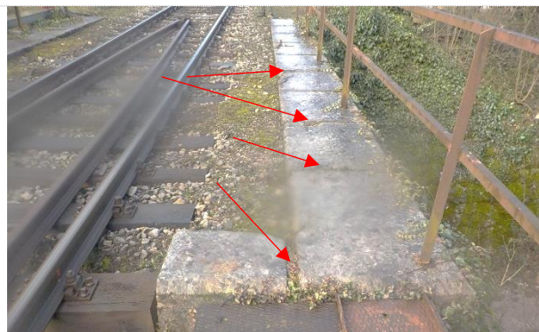
sl.50- opornik stran Sežana: primer desnega krila / ograjni venec - propadle fuge med kamni / v celoti
