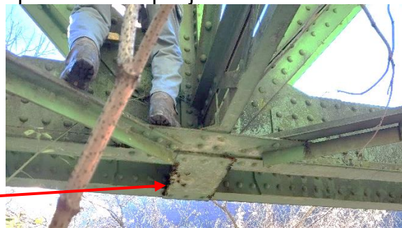
sl.2- pogled na vezno pločevino glavnega paličnega nosilca s spodnje strani: Sanacija: v sklopu PKZ
