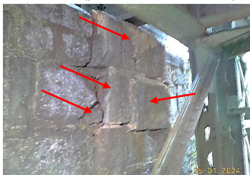
sl.61- poškodovani kamni za odstranitev, izsekavanje ostanka na način, da praznina-to je manjkajoči del v blokih predstavlja obliko kvadra
