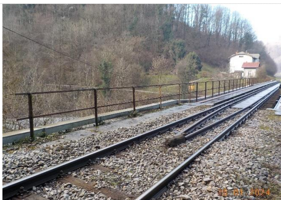
sl.51- opornik stran Jesenice: primer levega krila / ograjni venec - propadle fuge med kamni / v celoti
