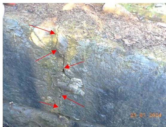
sl.58- opornik stran Sežana/gorvodno: nepomično ležišče : vertikalne razpoke kamnitega bloka
