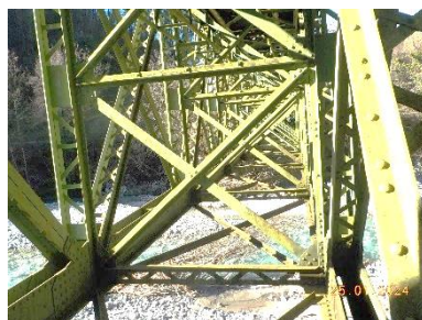
sl.18- lokalna korozija – površine v spodnjem delu premostitvene konstrukcije
