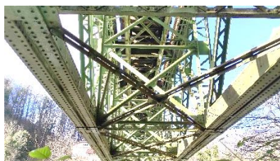
sl.17- lokalna korozija – površine na spodnjem delu premostitvene konstrukcije
