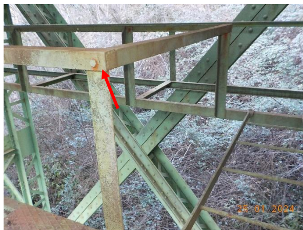
sl.10- ograja v servisnem hodniku / gorvodna stran / nad ležiščem stran Jesenice pri vstopu na vmesni podest: majav vijak pritrditve ograje na stebriček Sanacija: DA
