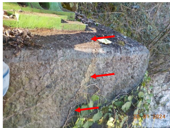
sl.36- opornik stran Sežana: dolvodno ležišče: – kamniti blok – razpoka na čelni strani
