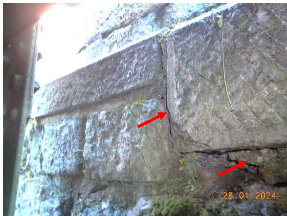
sl.40- opornik sek. vzdolžnika stran Jesenice: dolvodno posedel kamniti blok / preperela fuga ob in pod kamnom
