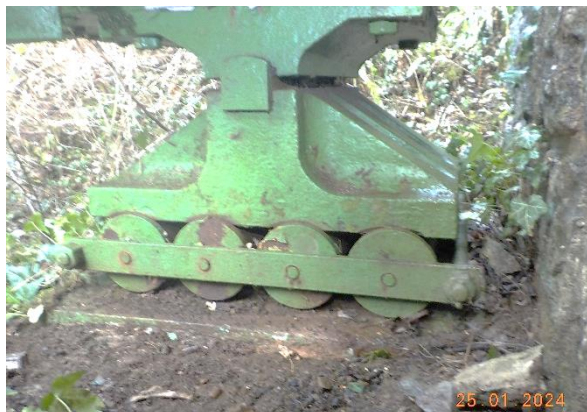
sl.26-opornik stran Jesenice: dolvodno ležišče
