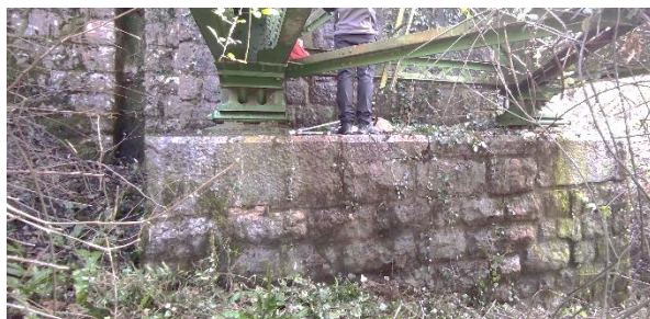
sl.24- opornik stran Jesenice: lokalno razpadle fuge razpoke na kamnih ležiščnih blokov, poraščenost z vegetacijo
