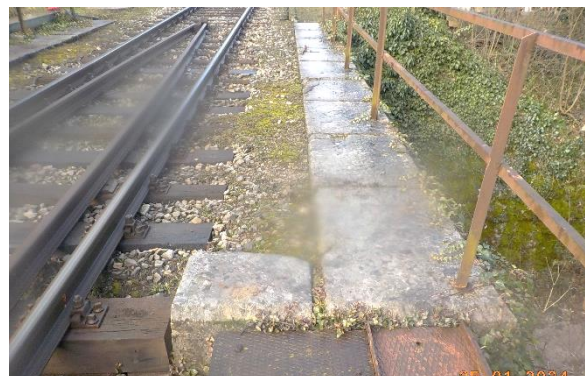
sl.23- desno krilo stran Sežana: razpadle fuge med kamni, poraščenost z mahom
