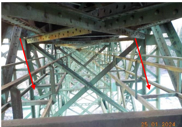
sl.7- servisna hodnika znotraj nosilne konstrukcije pod nivojem tirov – sta brez pohodnih elementov (po projektni nalogi zahteva za vgradnjo pohodnih rešetk) Sanacija: DA, vgradnja rešetk
