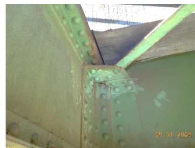
sl.19- lokalna korozija – priključne pločevine pod nivojem pragov (v zgornjem delu premostitvene konstrukcije)
