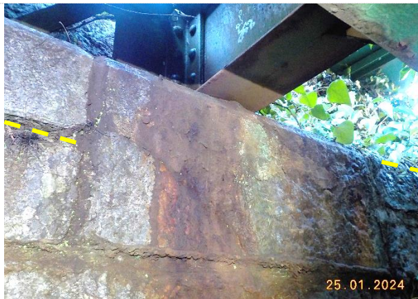
sl.54- oporni zid sekundarnega vzdolžnika-stran Sežana/dolvodno: lokacije preperelih fug med kamni pod drsnim ležiščem
