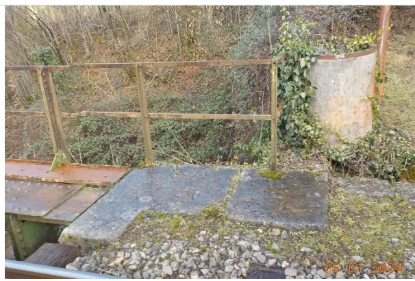
sl.52- opornik stran Jesenice: primer desnega krila / ograjni venec - propadle fuge med kamni / v celoti
