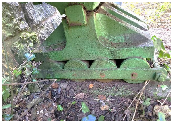
sl.27-opornik stran Jesenice: gorvodno ležišče
