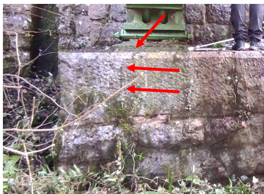
sl.28-dolvodno ležišče: kamniti blok – razpoka, fuge lokalno preperle
