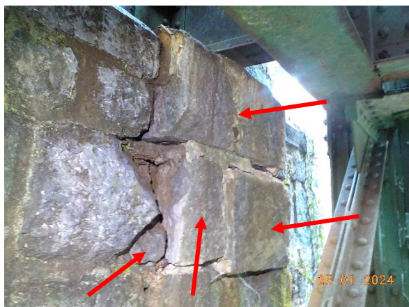
sl.42- opornik sek. vzdolžnika stran Jesenice: gorvodno razrinen/razpokan blok pod ležiščem, razpokana še dva kamnita bloka pod ležiščnim
