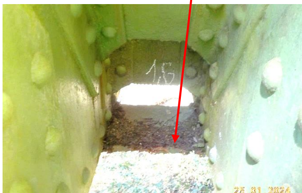
sl.3- pogled na vezno pločevino glavnega paličnega nosilca s spodnje strani: Sanacija: v sklopu PKZ (močno korodirano na robovih pločevine)
