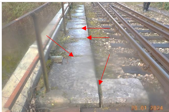
sl.49- opornik stran Sežana: primer levega krila / ograjni venec - propadle fuge med kamni / v celoti
