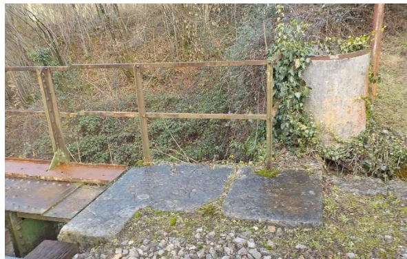
sl.12- ograja na desnem krilu opornika stran Jesenice - ni ugotovljenih odstopanj / del v nadaljevanju prečno na krilo močno poraščen
