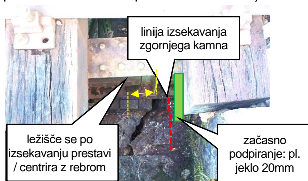
sl.62- pogled od zgoraj na drsno ležišče: linija poravnanja kamnitega bloka pred betoniranjem, namestitve ležišča v izhodiščno lego, začasno podpiranje konca profila
