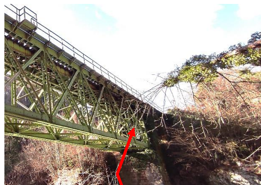
sl.4- dolvodni glavni palični nosilec: diagonala nosilca med osemama 0-1: močna plastična poškodba robu elementa Sanacija: NE
